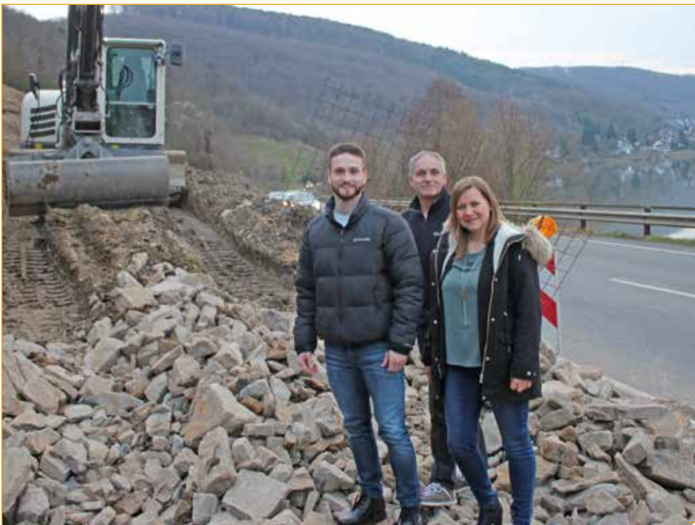
Erfreut über den in der zweiten Jahreshälfte anberaumten Start des Ausbaus der Bundesstraße 49 zwischen Lay und Moselweiß mit begleitendem Radweg ist die Layer CDU-Vorsitzende Daniela Nowak zusammen mit Beisitzer Thomas Jost und dem stellvertretenden Vorsitzenden Robin Scharbach (von rechts).
