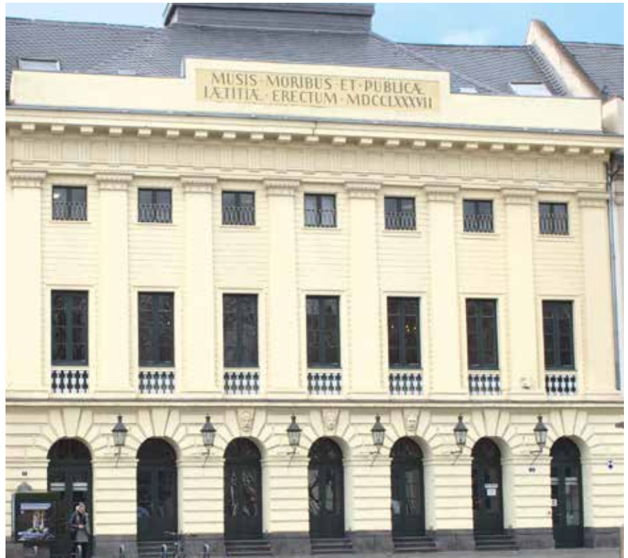
Das städtische Theater wird kernsaniert.
